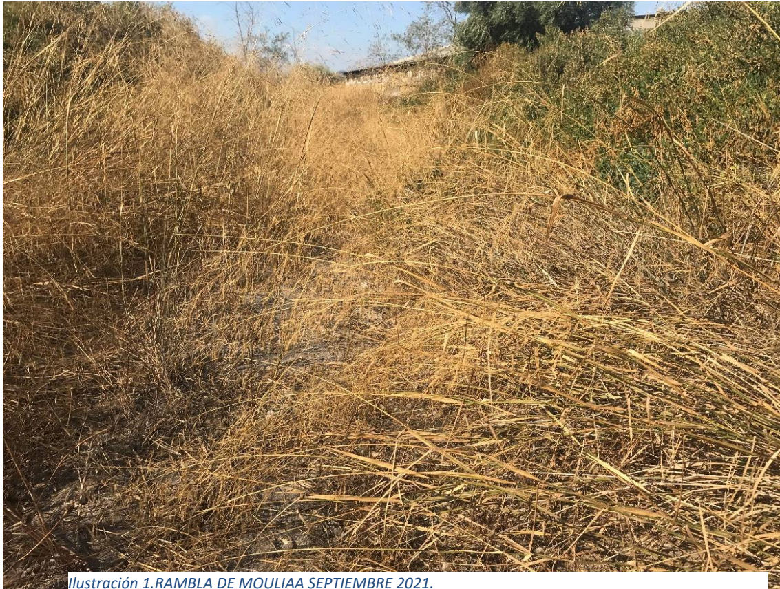
Ilustración 1. RAMBLA DE MOULIAA SEPTIEMBRE 2021.
